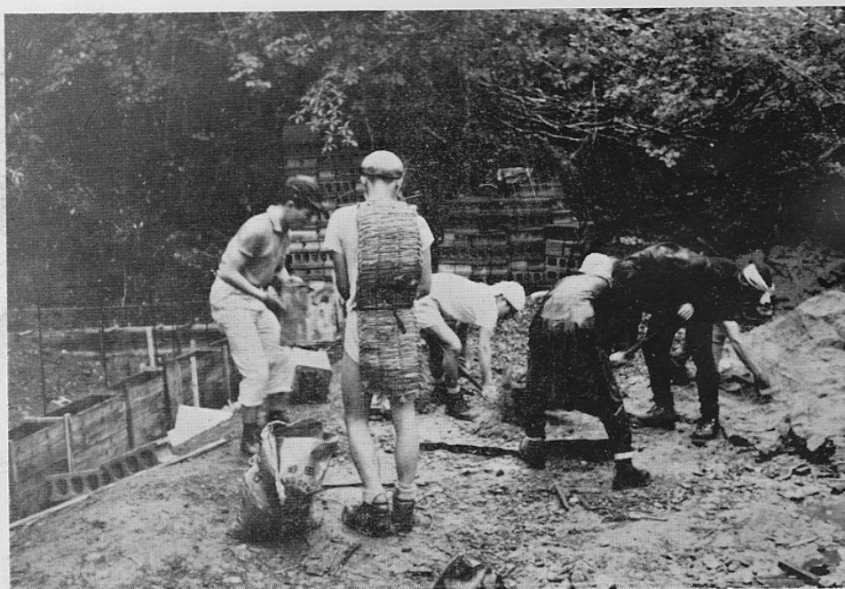
5月27日 工期が遅れたので、雨をついての基礎コンクリート打となる
